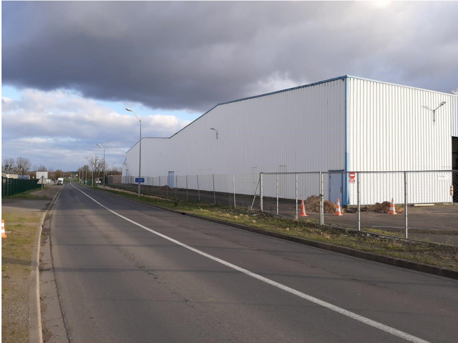
Point de vue 5 – environnement proche
