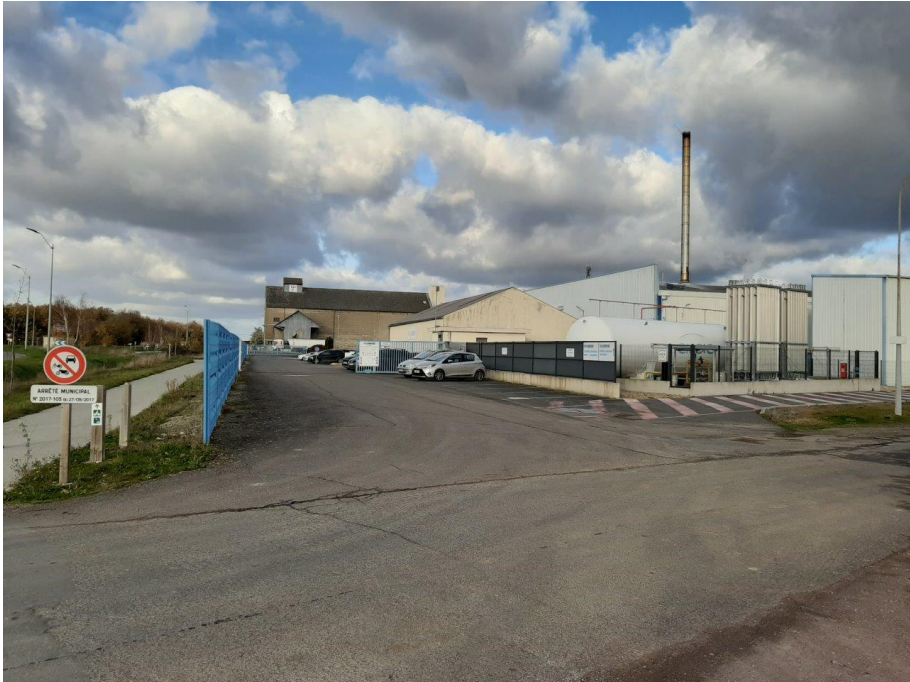
Point de vue 11 – environnement proche
